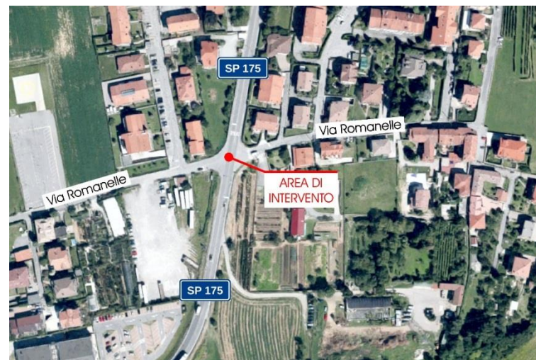
Figura 3 – Area di intervento – Stato di fatto
