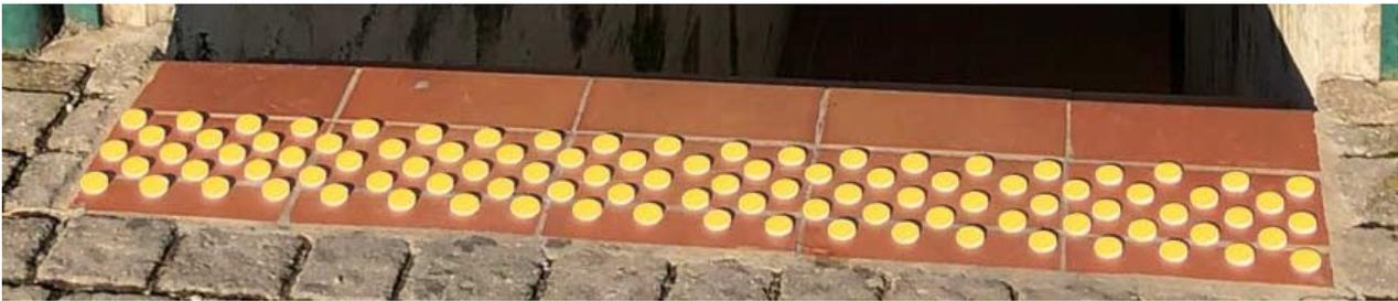
Ausili per ciechi e ipovedenti sono indispensabili per assicurare la sicurezza anche nell'utilizzo di scale. Il posizionamento di segnalazione di fonti di pericolo: deve essere colorato per creare il contrasto visivo e tattile con il pavimento nel caso di ipovedenti, ed in risalto per risultare percepibili anche dai ciechi.
